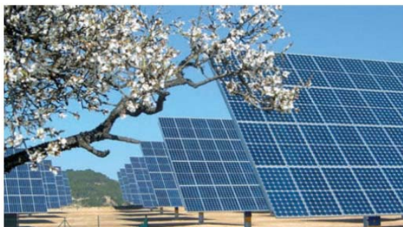
第二代薄膜电池必将促使全世界大型太阳能电站发展到一新的高度
