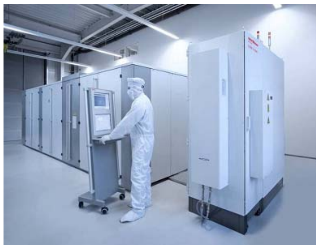
激光切割，为电池分区
